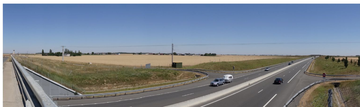
Multiplés franchissements de l'A19 offrent des vues lointaines sur le territoire concerné. Les silhouettes allongées des hameaux et d'Aschères-le-Marché délimitent la plaine agricole au Nord de l'autoroute.
