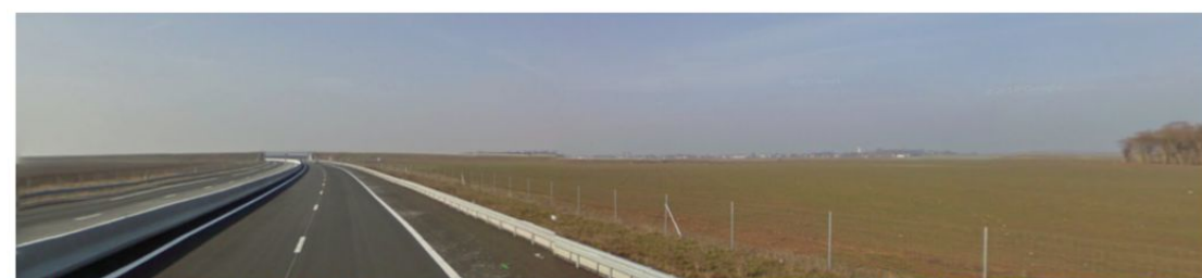
8. L'A19 traverse une séquence rythmée par les franchissements et les talus de raccordement masquant les vues latérales à proximité du site d'étude. La silhouette étirée d'Aschères-le-Marché dessine l'horizon lointain.
