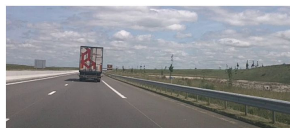
3-4. Suit une séquence marquée par une succession de talus, d'ouvrages connexes et de franchissements qui engendrent des fermetures visuelles qui seront renforcées plus tard par la végétation.
