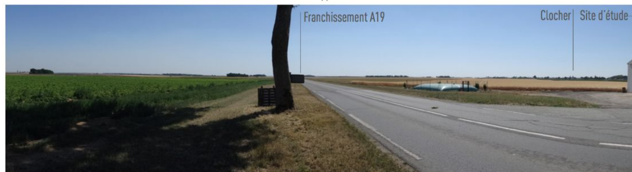
8. Trois arbres isolés qualifient la route à proximité du hameau Bel Air, où l'on découvre le tracé de l'A19 compte tenu de l'inclinaison du plateau vers le Sud (franchissement masqué par le panneau). La forêt d'Orléans marque à l'horizon clairement la fin du plateau des grandes cultures.
